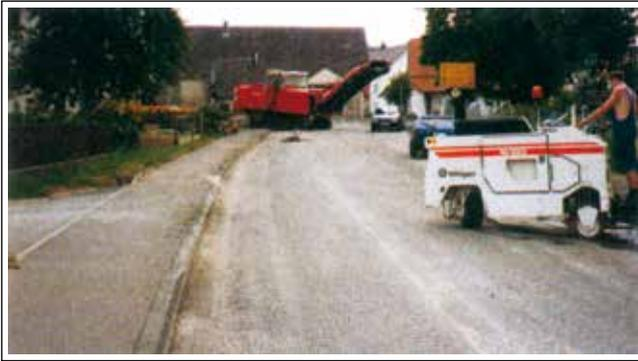
**Figura 32:** Fresadoras de pequeno e grande porte trabalhando juntas
