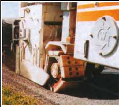
**Figura 46:** Equipamento com “falsa roda” para execução da fresagem para sonorização
