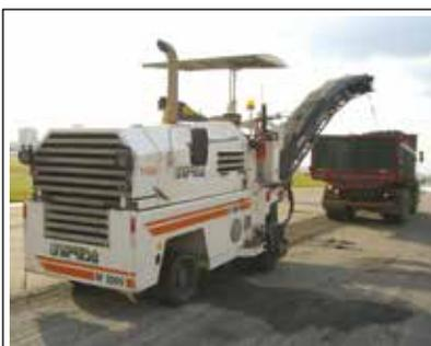
Fresadora W 1000, da Wirtgen
