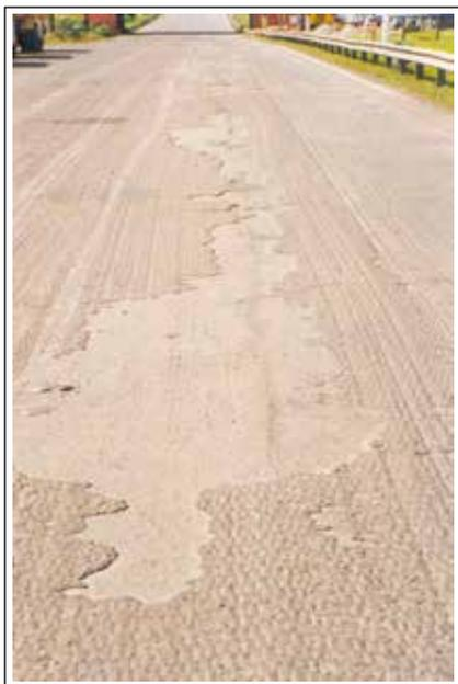
**Figura 54:** Descolamento de “placas” em locais fresados após a liberação ao tráfego
