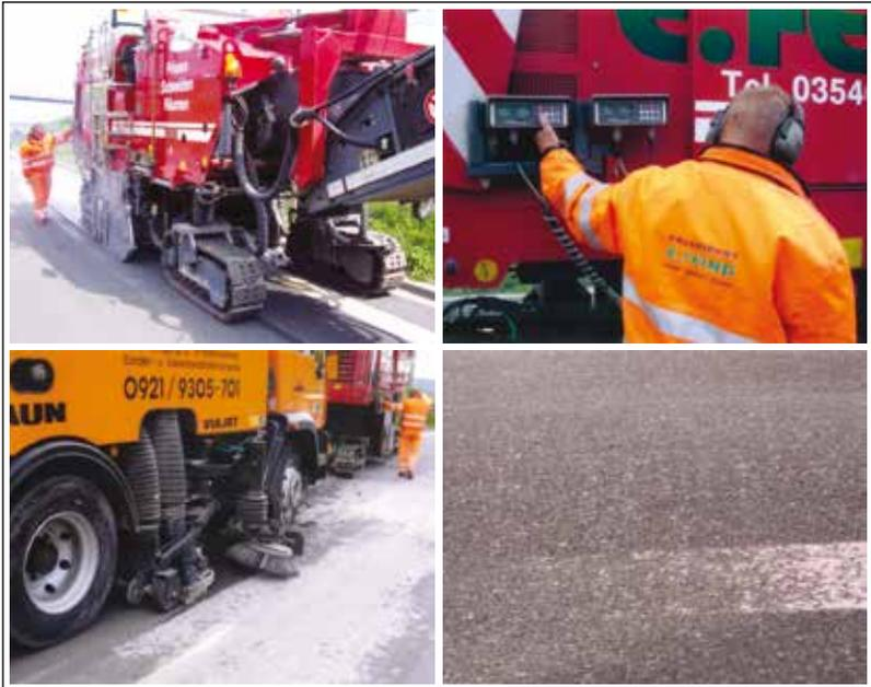
**Figura 13:** Execução de microfresagem para correção do perfil longitudinal da pista
