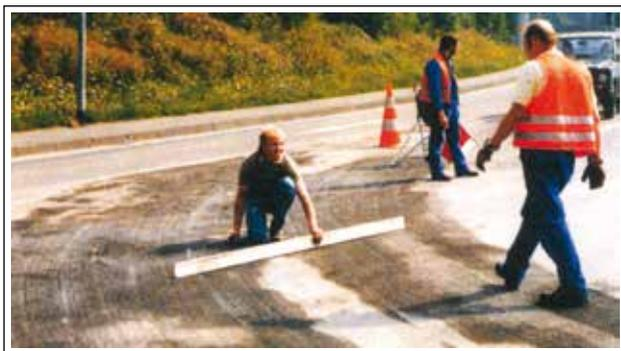
**Figura 39:** Fresagem de regularização da pista
