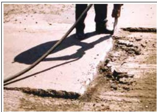
**Figura 35:** Arremate com rompedor pneumático
