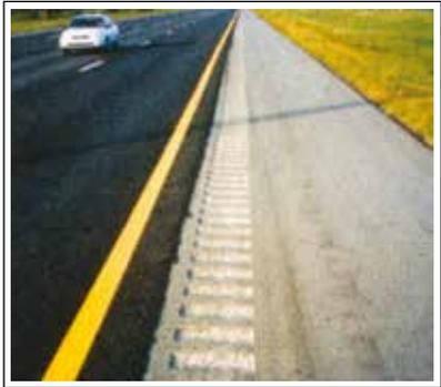
**Figura 47:** Resultado na pista da fresagem para sonorização
