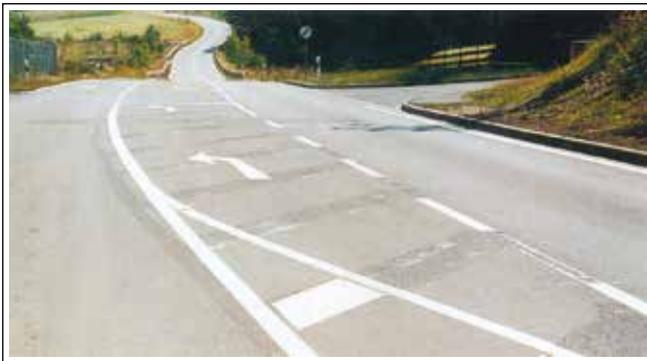
**Figura 11:** Layout viário alterado utilizando a microfresagem do revestimento
