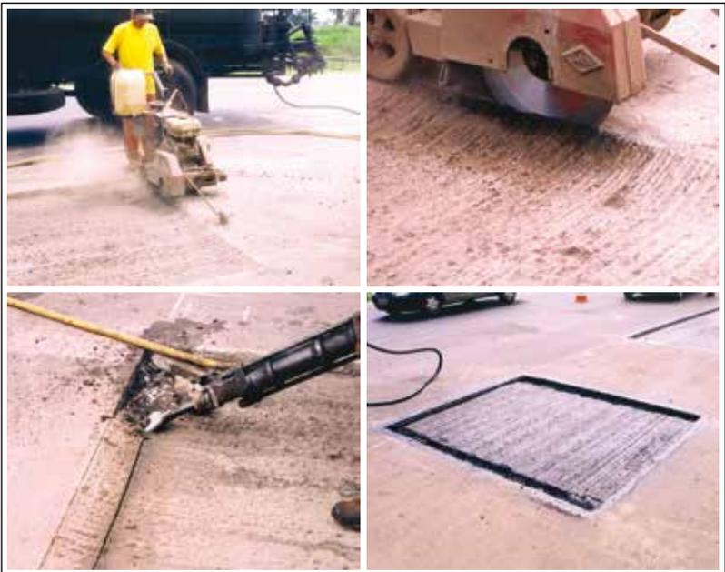
**Figura 34:** Procedimento para arremate no início e final dos cortes, para melhor ancoragem da camada asfáltica
