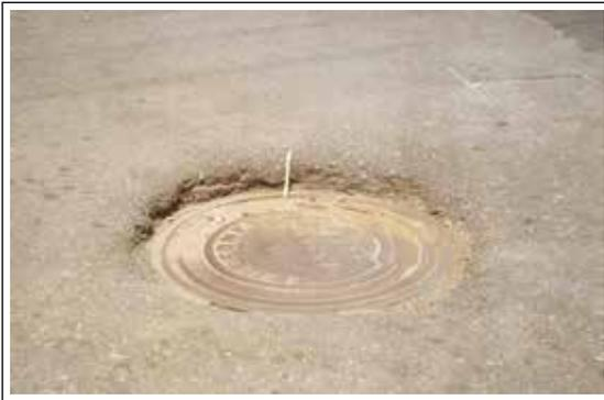
**Figura 52:** Desnível de 10 cm entre a pista e o tampão de ferro, resultado de dois recapeamentos sem a retirada do revestimento anterior
