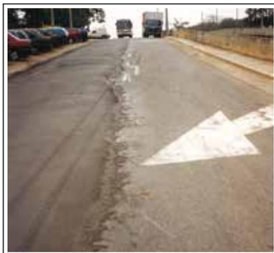
**Figura 50:** Remendo sobreposto no pavimento existente
