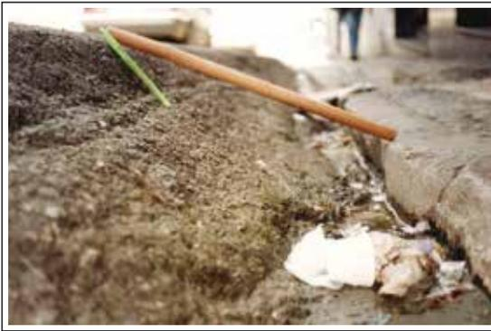
**Figura 49:** Sobreposição de revestimentos asfálticos sem a retirada das camadas anteriores
