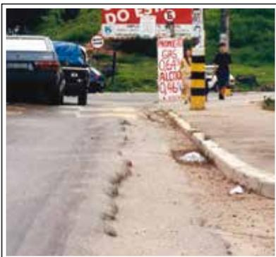
**Figura 51:** Deformação plástica do revestimento
